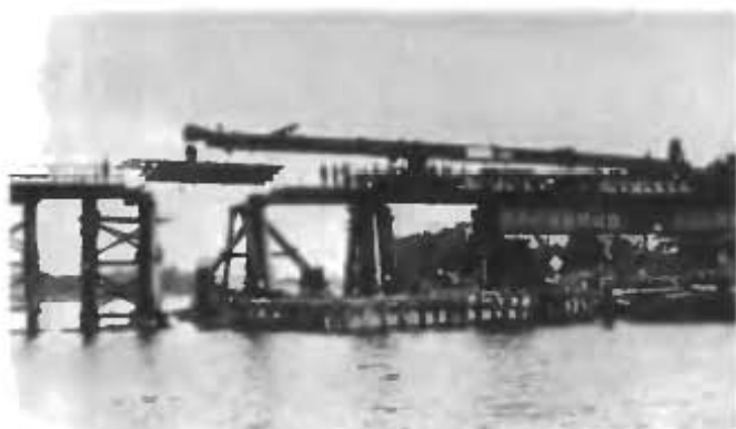
Разборка 3-х пролетов старого моста для строительства железо-бетонной опоры.
