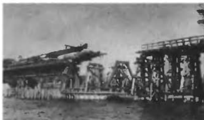
Разборка 3-х пролетов старого моста для строительства железо-бетонной опоры.
