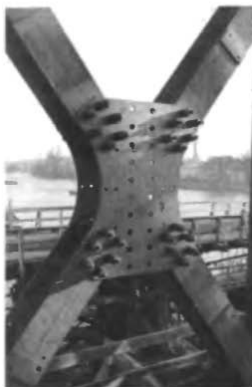
Монтажный узел фермы
