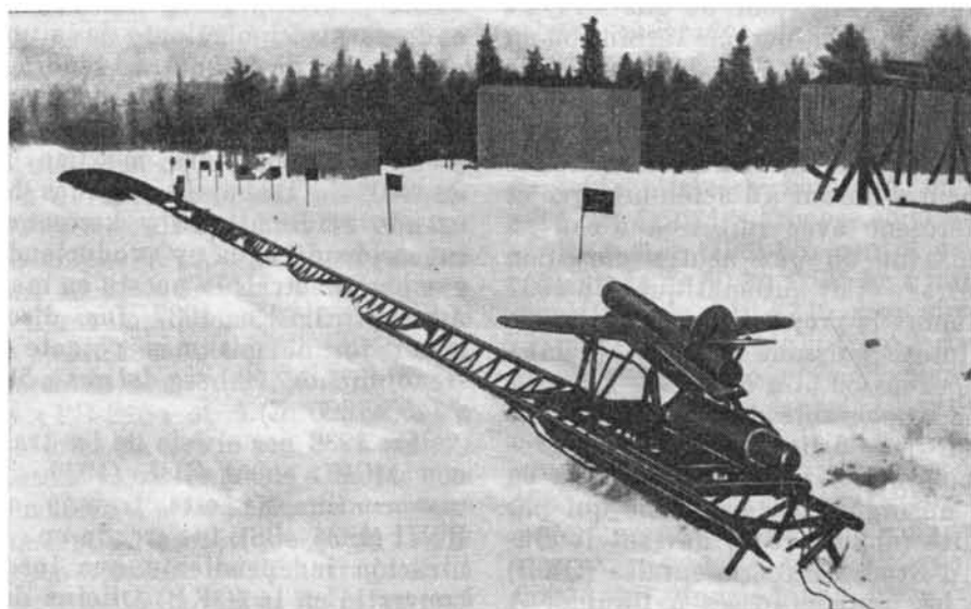
Fig. 19. Fusée ailée à guidage automatique « 212 » avec le moteur « OPM-65 ». Elle fut essayée 13 fois au sol en 1937—38 et 2 fois en vol en 1939.
