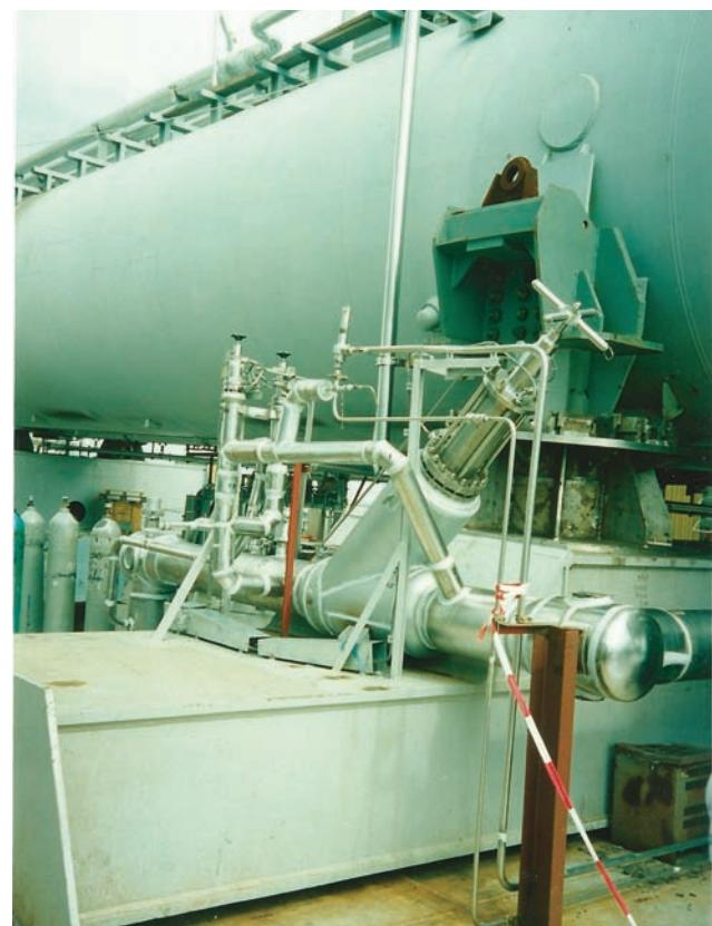
Рис. 22. Незащищенная от газодинамического и теплового воздействий арматура емкостей кислорода на СП
