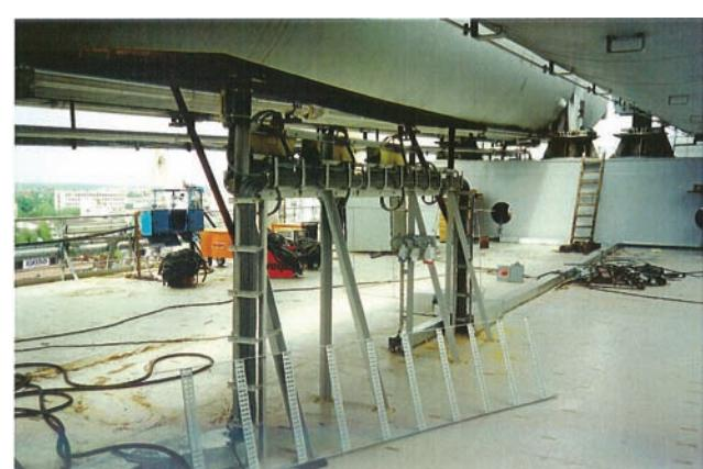
Рис. 23. Незащищенные от газодинамического и теплового воздействий емкости кислорода и их арматура на СП
