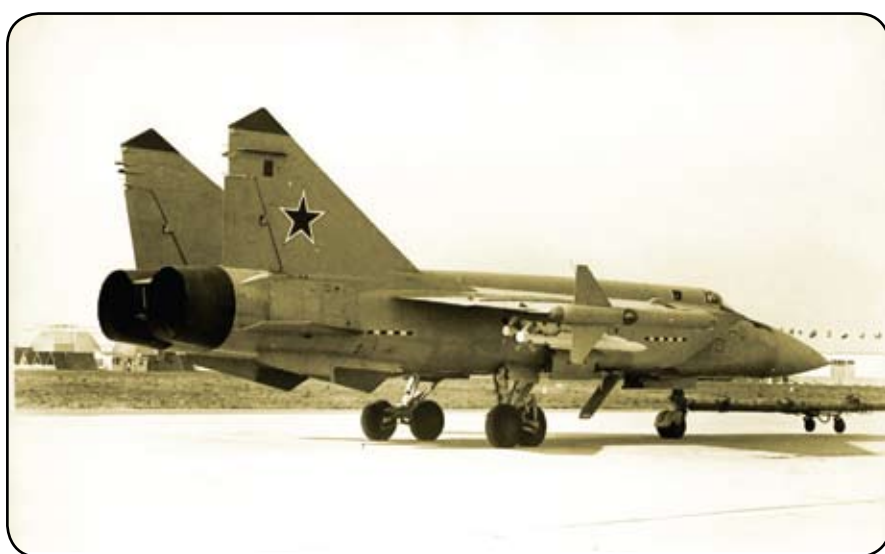
Седьмой опытный МиГ-31М — хорошо видны контейнеры системы постановки помех с «ластами» на крыле и новая хвостовая часть без наружных управляемых створок сопел двигателей. Фото: С.Г. Мороз
