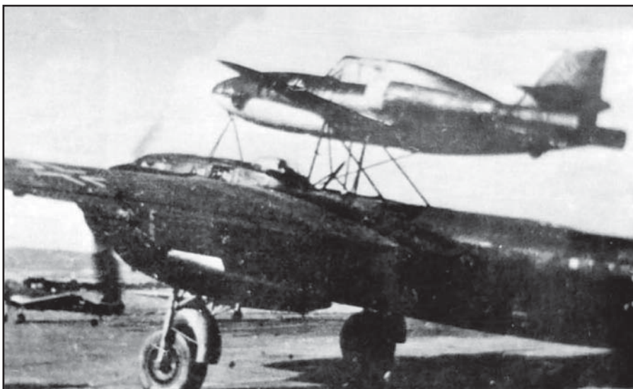
Самолет Me 328B задумывался как пилотируемый снаряд, буксируемый за тяжелым бомбардировщиком. Его первый опытный образец испытывался с борта носителя Do 217E
