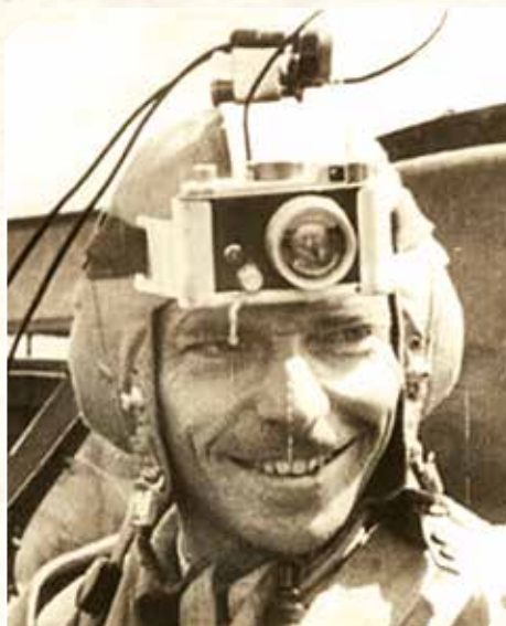
Рудольф Опитц установил у себя на шлеме фотоаппарат для видеофиксации приборной доски Me 163 во время полетов на больших скоростях
