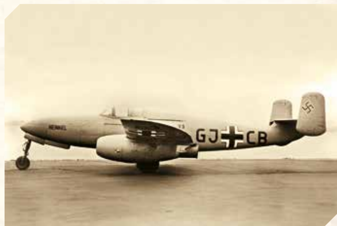
Контрольное фото третьего прототипа He 280V-3 с двигателями HeS 8A перед началом испытательных полетов в июле 1942 г.
