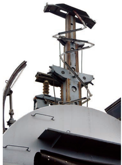
Частично поднятое устройство отведения и закорачивания контактной сети
