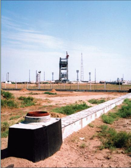
Лотковая канализация для прокладки оптоволоконна
