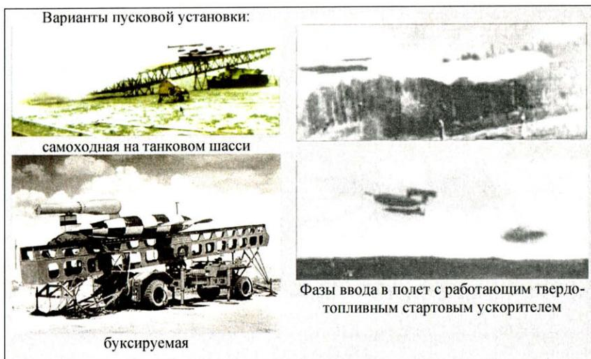
Рис. 2.21. Система старта КР наземного базирования 10ХН
