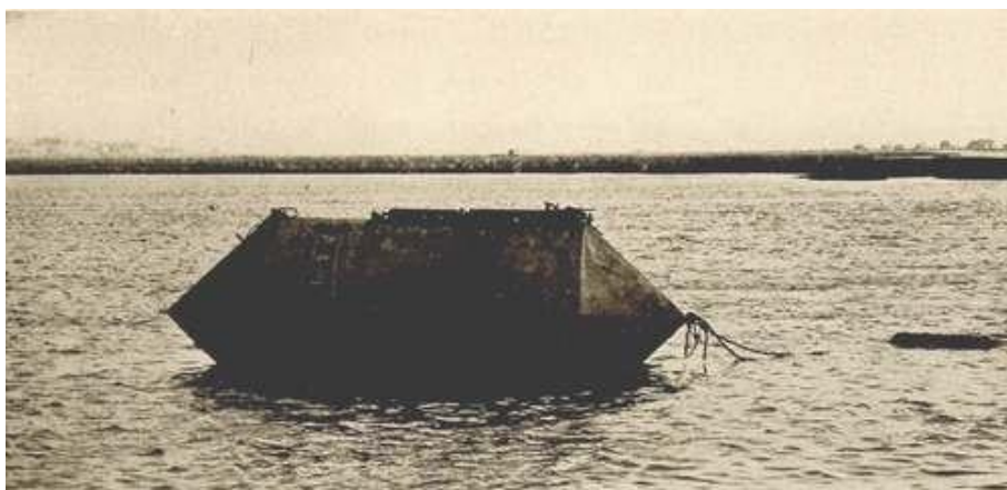
Погружающаяся баржа для подъёма рассыпных или мелких грузов с морского дна, построенная в 1899 г. Лейк использовал её в 1900 г. для публичной демонстрации.
