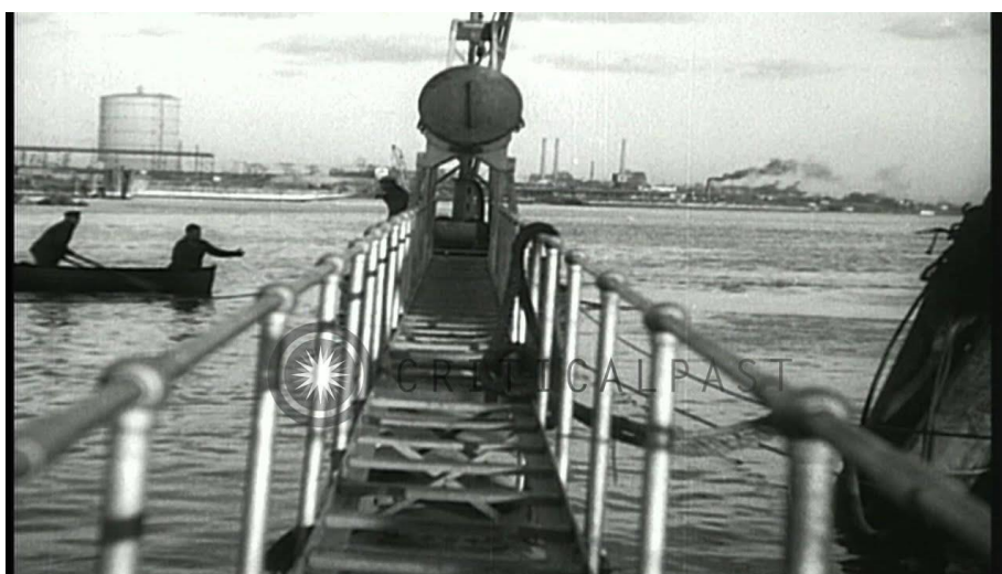
Трап с судна обеспечения к трубе, опущенной на морское дно
