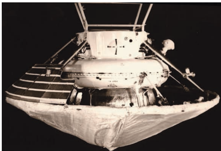
рисунок 8. Общий вид СА с коническим аэродинамическим экраном и ПМ АМС «МАРС»
