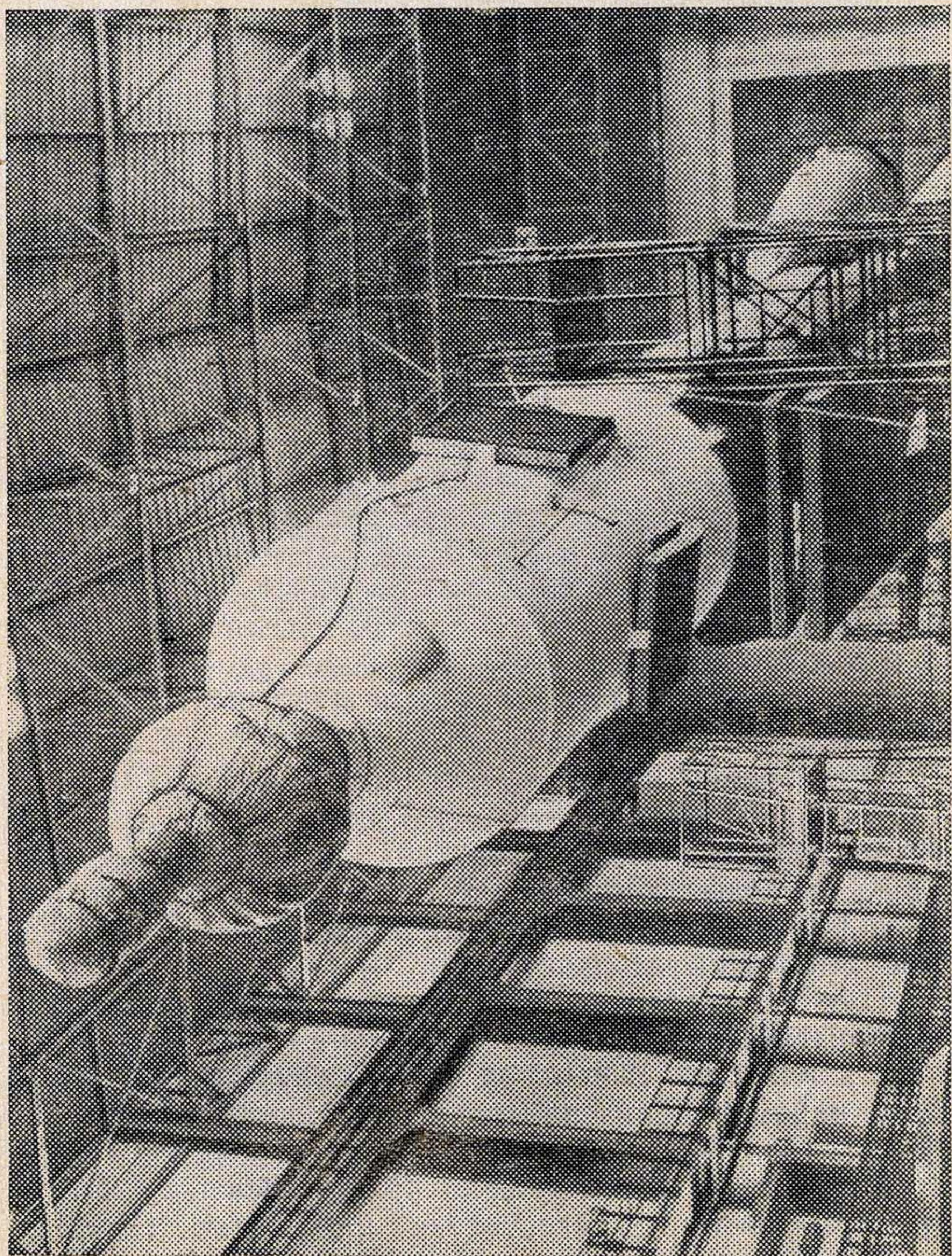
тажно-испытательного корпуса, а затем с помощью мостовых кранов переносят в верхнюю часть. Здесь расположены выдвижные площадки, создающие ряд ярусов, позволяющих производить круговое обслуживание собираемой ракеты-носителя. Некоторые из этих площадок могут передвигаться в вертикальном направлении.
