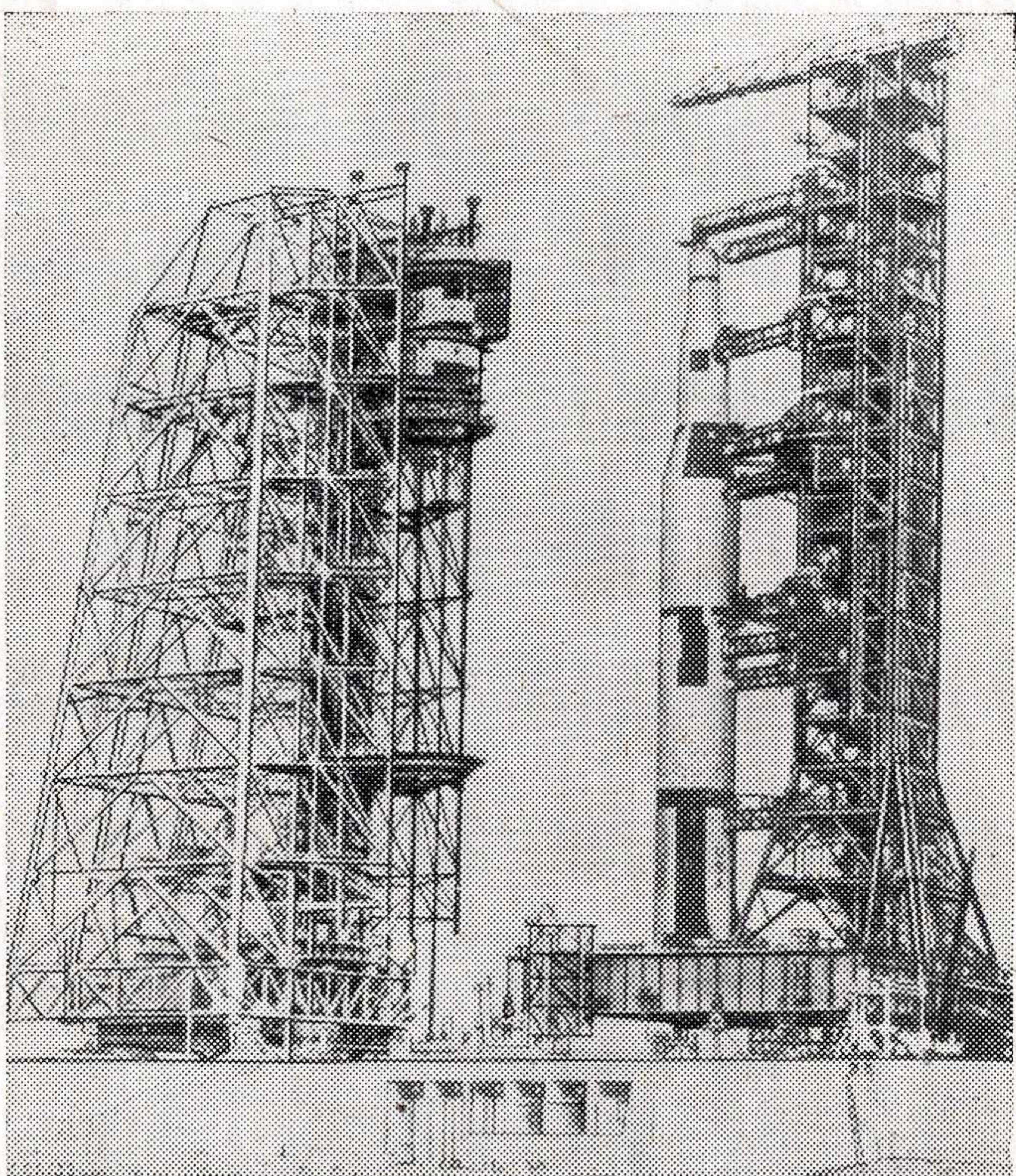
Рис. 11. Стартовая позиция ракеты-носителя «Сатурн-V». Справа: стартовая платформа с ракетой и кабель-заправочная башня. Слева: мобильная башня обслуживания, отведенная от ракеты.
