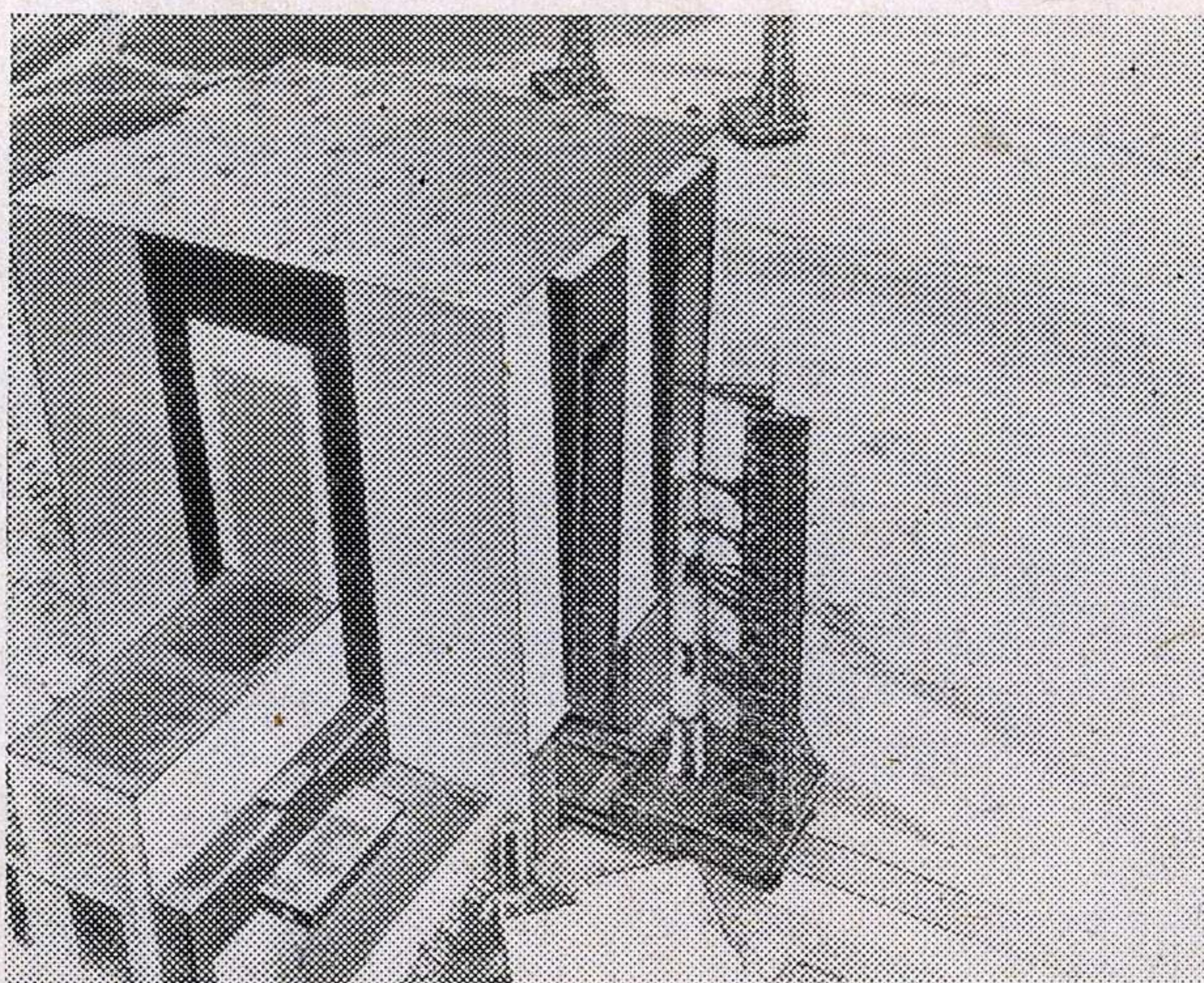
Рис. 5. Монтажно-испытательный корпус для вертикальной сборки ракеты-носителя «Сатурн-В».
