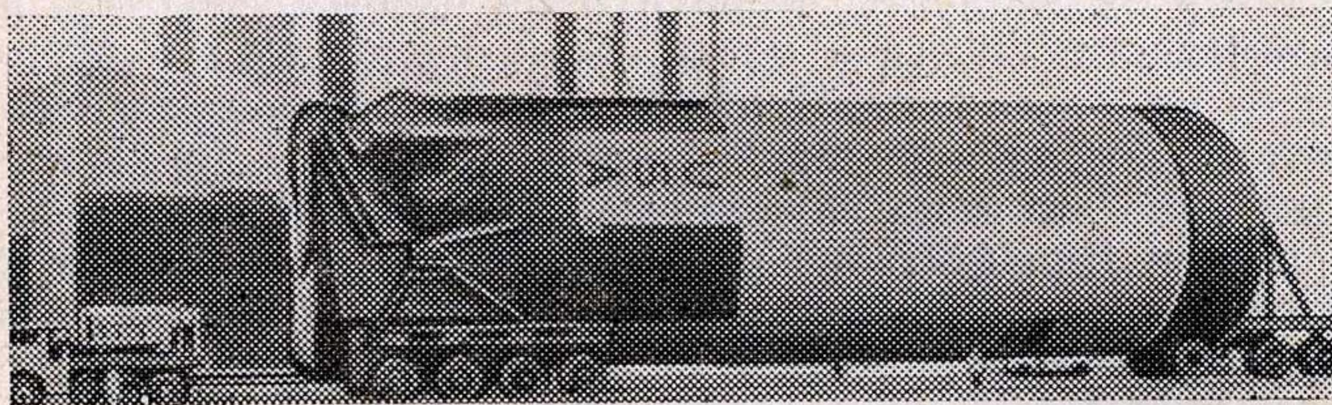
Рис. 3. Транспортировка ступени ракеты на грунтовом транспортере.
