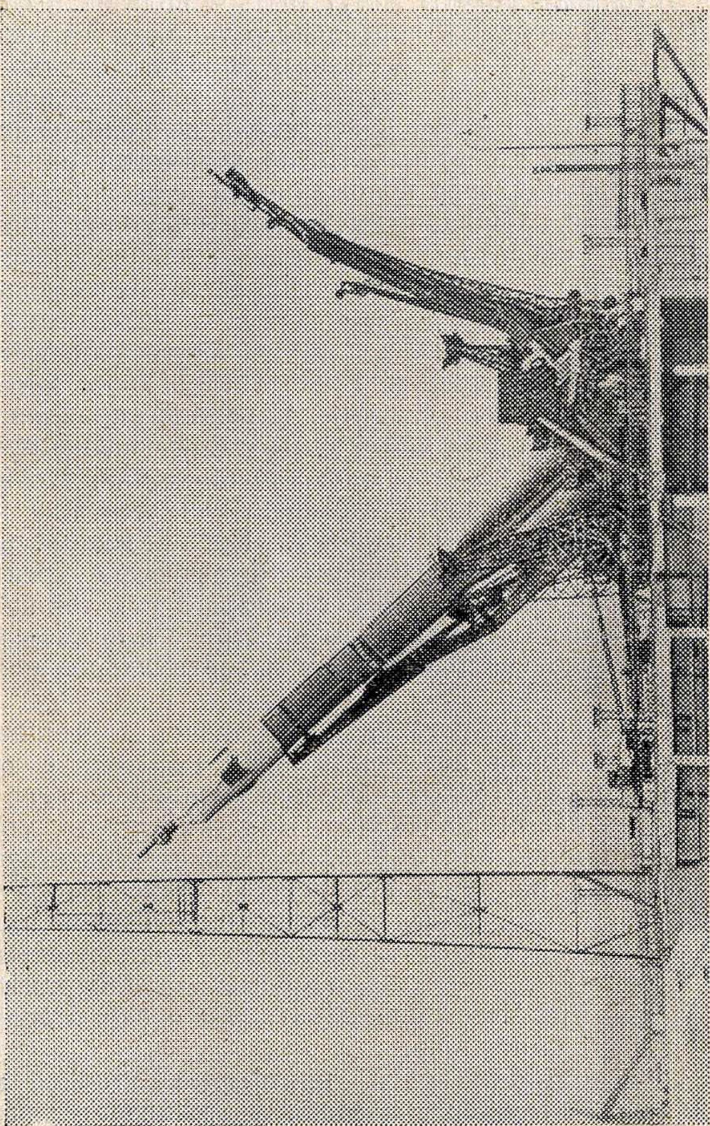
Рис. 8. Установка ракеты-носителя с кораблем «Союз» на стартовое устройство.
