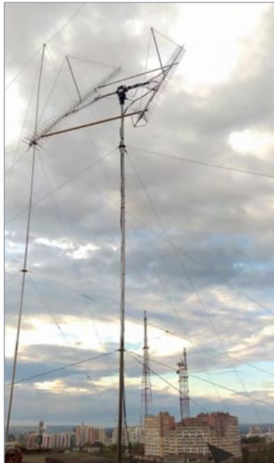
Рисунок 1.4.7.2. Внешний вид наземной антенны отраженного канала БиРЛК МКА «АИСТ-2Д», установленной на здании ПГУТИ (г. Самара)
