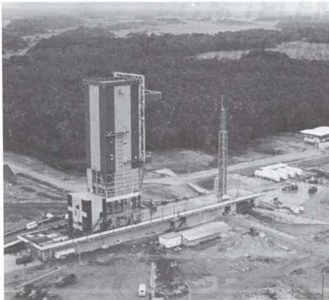
Figure 8 – The Ariane Launch Site (ELA) with the mounting tower and the umbilical mast/Ensemble de Lancement Ariane (ELA), avec la tour de montage et le mât ombilical.
