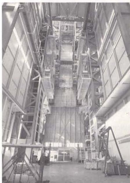
Figure 5 — Le chemin de roulement reliant la Zone de Préparation à la Zone de Lancement ELA-2
