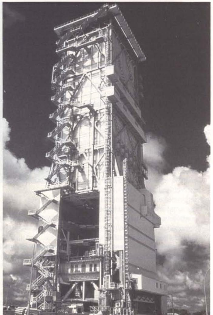
zone propre est équipée d'un pont de 12,5 t. Un ascenseur extérieur dessert les niveaux table de lancement et zone propre. Le Portique est reculé sur rails de roulement à une distance d'environ 80 m du lanceur lors du lancement.
