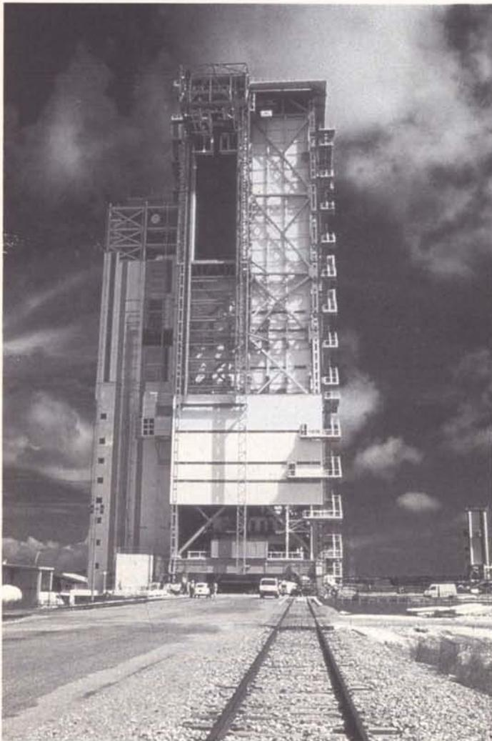
Figure 7 – Le Portique de servitude: abritée par le Portique on aperçoit la table de lancement Ariane-3
