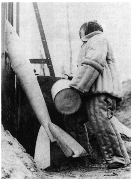
Fotografierpose von Klaus Riedel, Schutanzug für flüssigen Sauerstoff und Wasserstoff, stellte sich später als überflüssig heraus (Frühjahr 1931)
