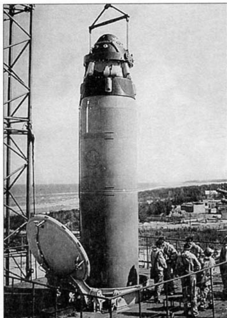
Погрузка ракеты РСМ-50 в шахту испытательного стенда
