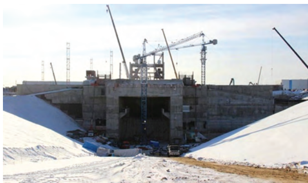
Рис. 4. Строительство космического ракетного комплекса
