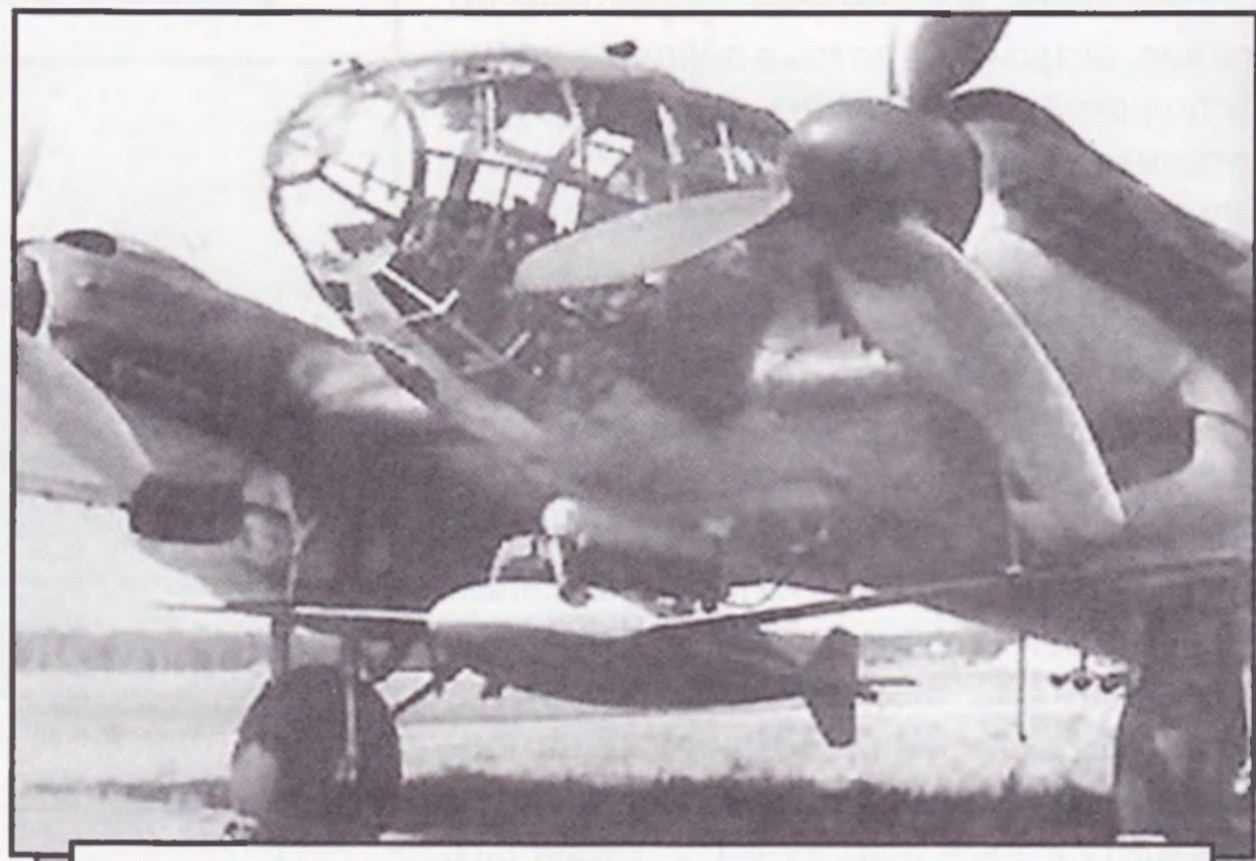
Самолет He 111H с планирующей бомбой дальнего действия BV 246 «Хагелькорн» под фюзеляжем
