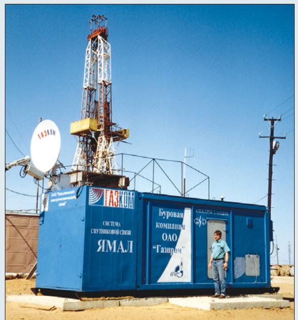
На крыше вагончика буровиков установлена станция VSAT
