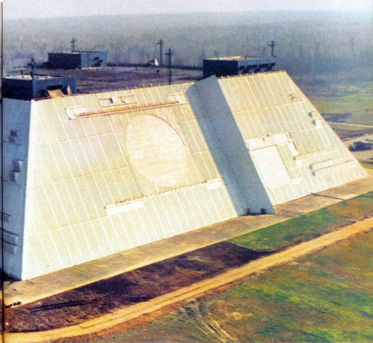
оружия расположены фазированные антенные решетки. В каждой решетке – 60 тысяч излучателей. Они работают уже десять лет, непрерывно сканируя пространство вокруг Москвы на расстоянии 3700 километров. По замыслам разработчиков, "ДОН-2Н" должен проработать еще как минимум лет тридцать.
