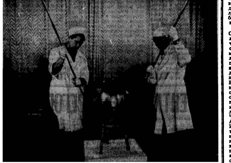
Монтаж первого искусственного спутника Земли ведут слесари-сборщики опытного завода Юрий Дмитриевич Силаев и Николай Васильевич Селезнев. Фото из архива ОКБ С. П. Королева. Публикуется впервые.
