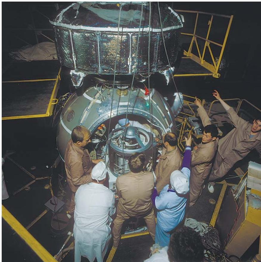
*Установка отсека с приматами в спускаемый аппарат КА «Бيون»*
