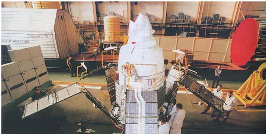
*Испытания КА «Молния-3» на техническом комплексе*
