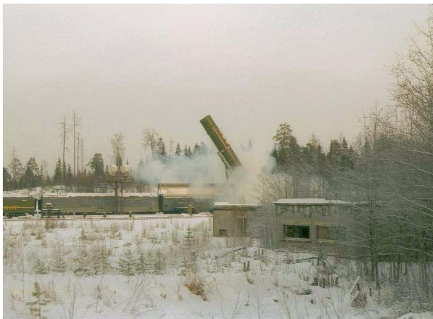
*Подъём ТПК в ходе пуска МБР РС-22 железнодорожного базирования*
