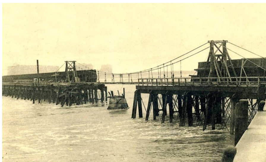
Подорванный виадук (длина разрыва 66 м, ширина 20 м) с временным подвесным мостиком
