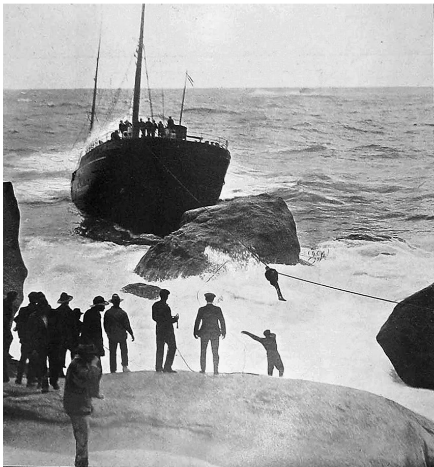
Трос с помощью пистолета Шермули перебросен и людей спасают
