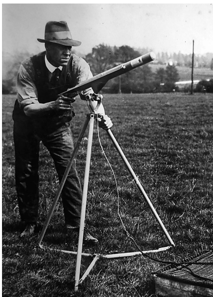
Эта ракетница Шермули бросала литье толщиной полдюйма на 320 м
