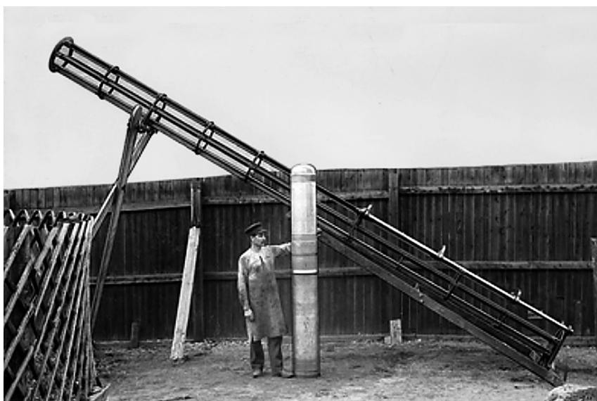
30-см двухступенчатая «торпеда» Унге и её пусковая установка
